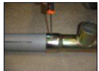
14. Fäst plaströret med medföljande skruv.
